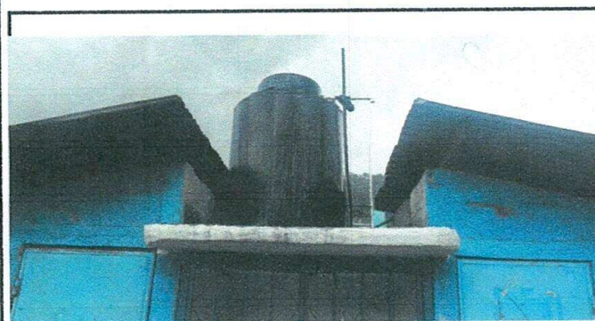
Foto 5: Hay dos Rotoplas que fueron colocados desde que fueron construidos los modulos de baños pero se colocó mal la entrada y salida de agua, además de eso se han deteriorado algunas piezas por lo que se
