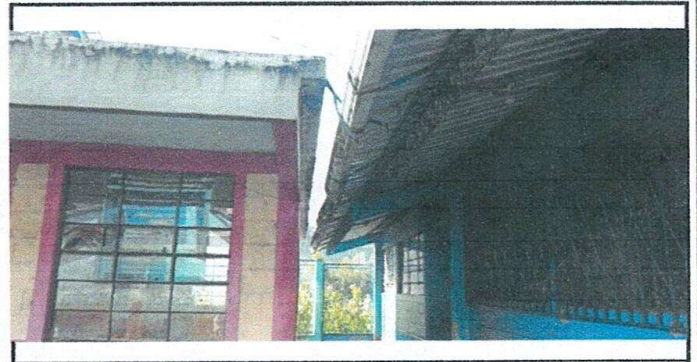
Foto 6: Todas las aulas tienen recolección de aguas a través de canaletas de pvc pero en algunas partes se han quebrado o caído por lo que se debe de sustituirlos
